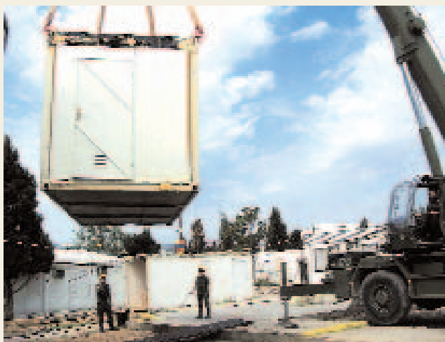
A los mandos de una grúa pesada, el cabo 1º Luis Enrique Ruiz Ferrer levanta uno de los centenares de contenedores que hay que repatriar después de limpiar y rehabilitar.
