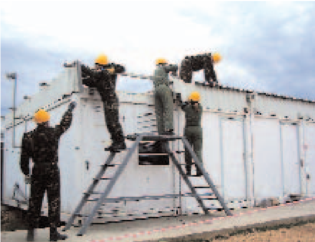
Los soldados de Salamanca y Burgos son los responsables de desmontar los contenedores donde estaban los dormitorios, oficinas y despachos.
